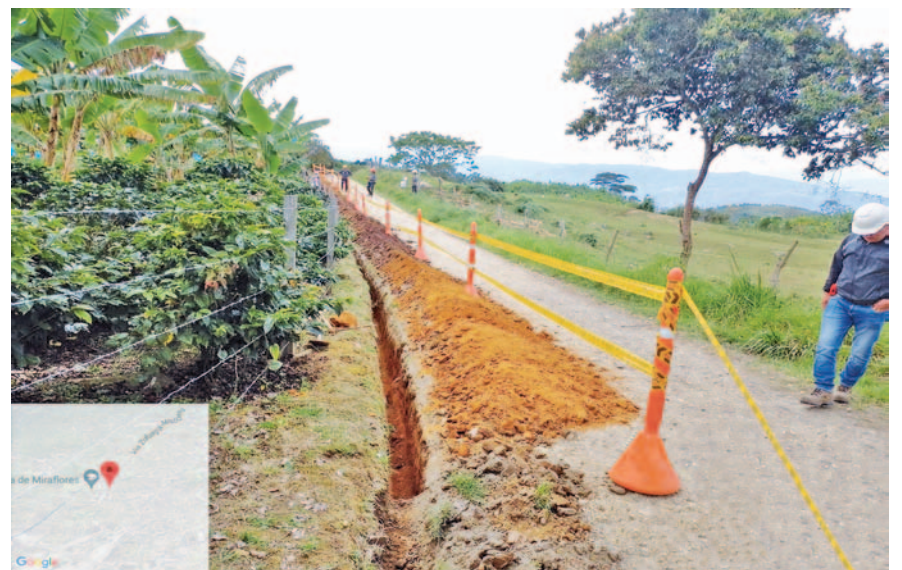
Inicio de obras de gasificación rural con gas social en la vereda La Pita del municipio de Garzón.
